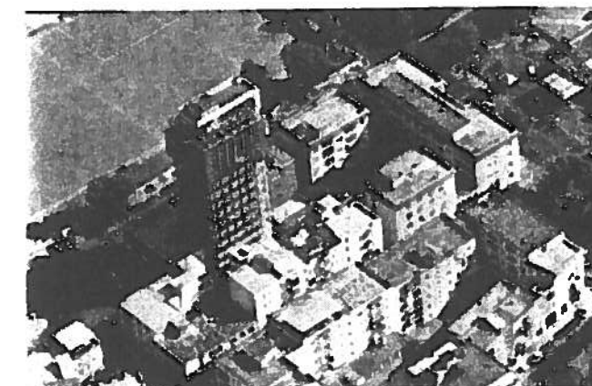
Particolare - Progetto Pilota, Ambito Sud Osservazione 16.
